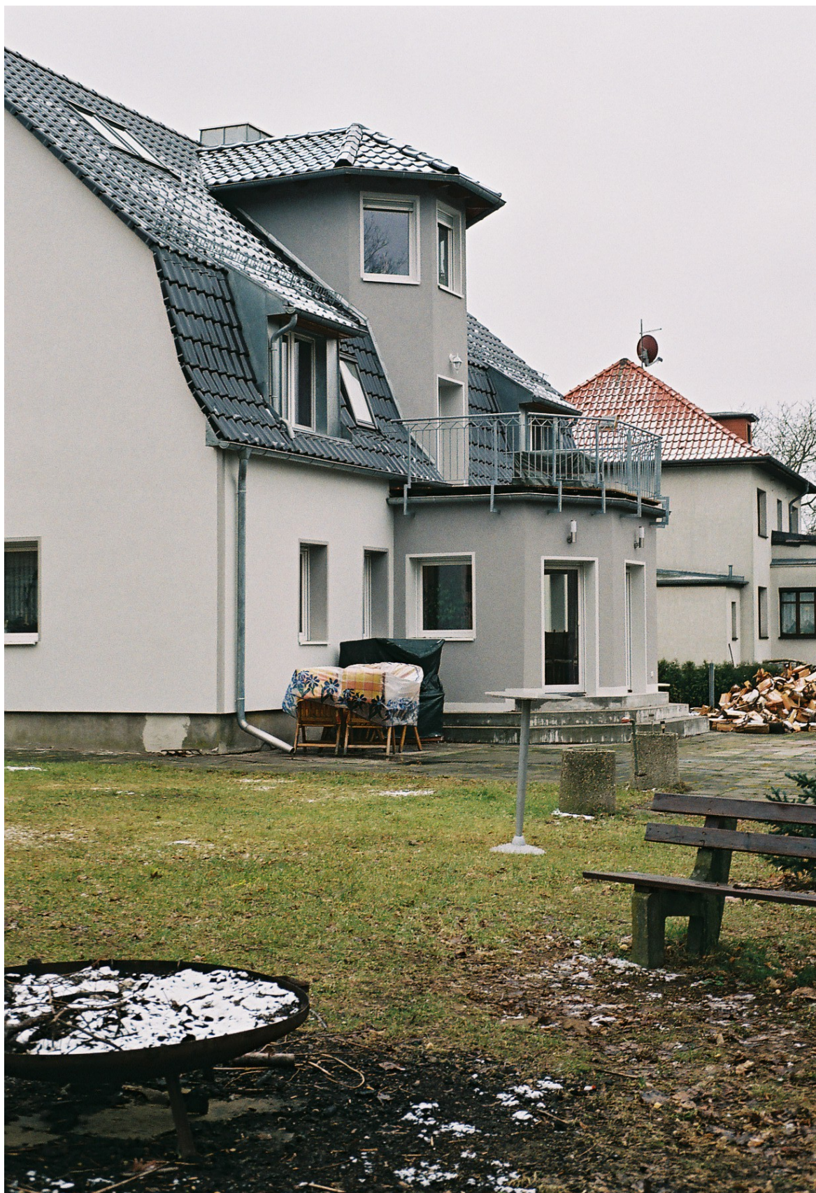
Villan i Berkenbrück i mars 2016, då nyligen hårt renoverad
