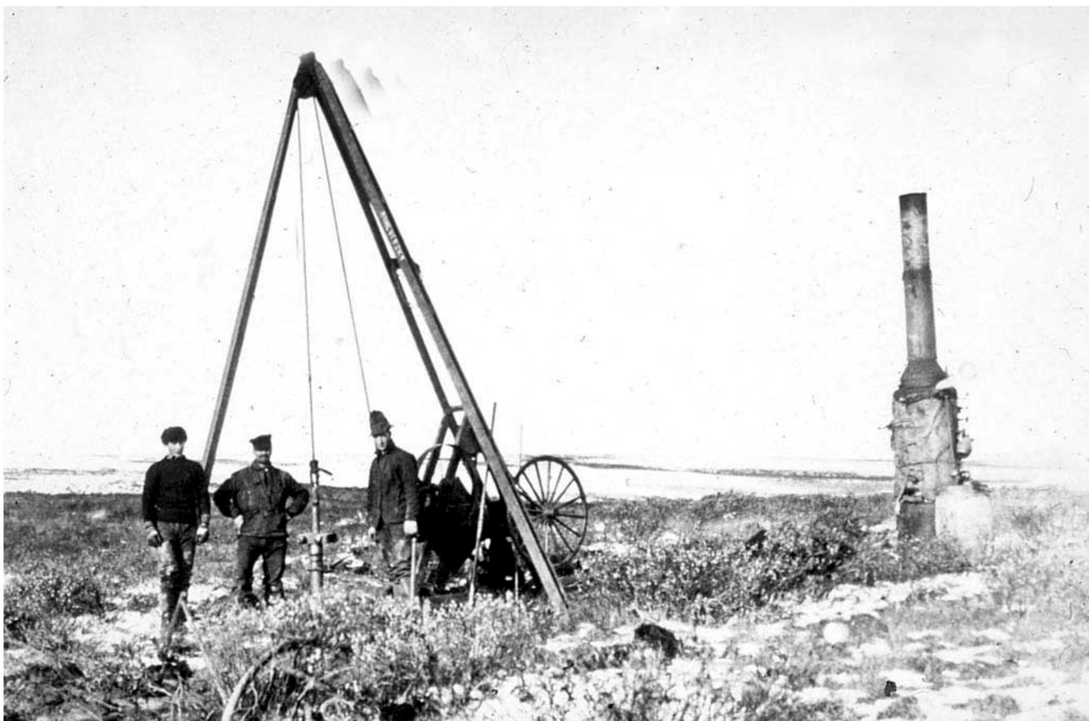
Med hjälp av en ångpanna försöker man tina upp den frusna jorden och gräva sig ner till guldsanden.
