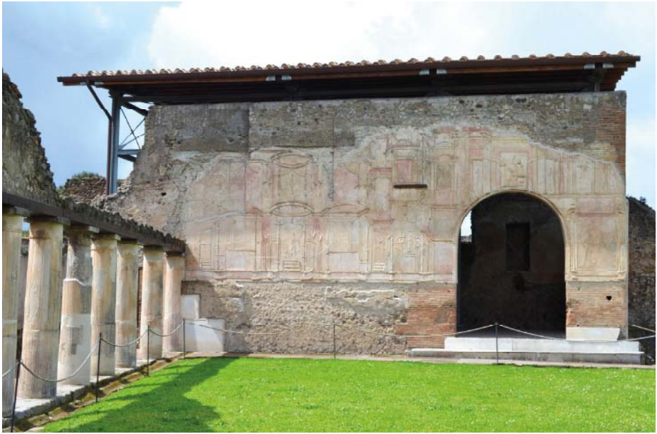
Pompeji. Del av de Stabianska termerna med en vackert dekorerad yttervägg.
